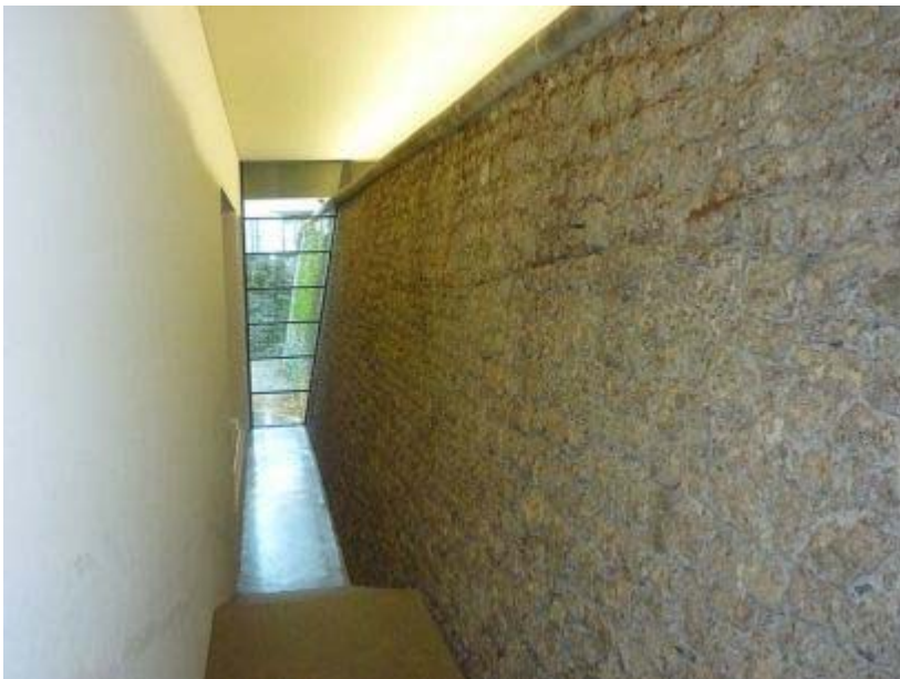
Mur d'enceinte de 1888
